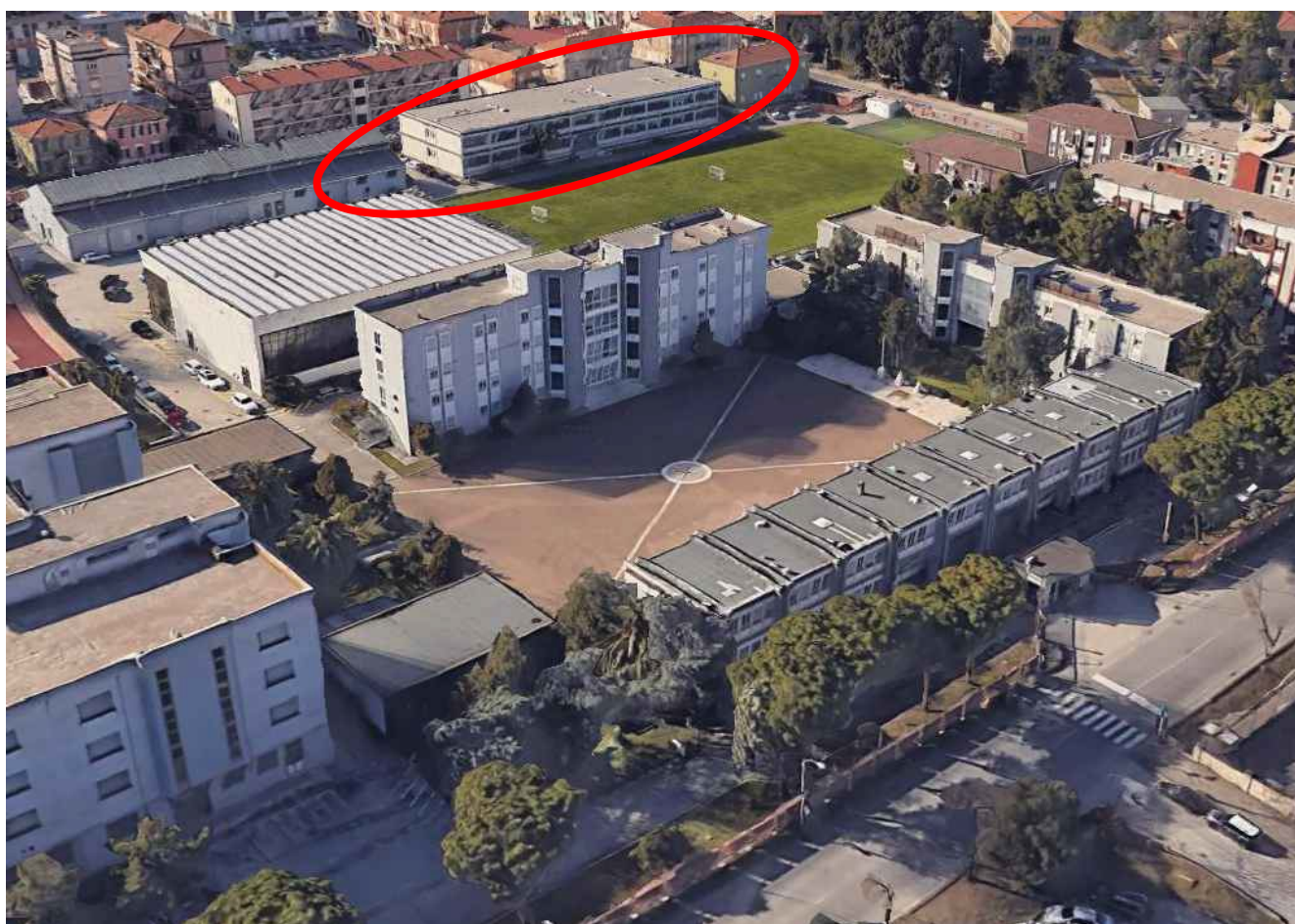
Fig. 1. Vista aerea del complesso
