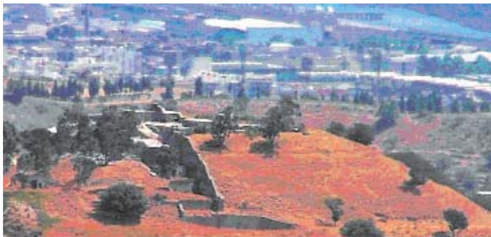
Fig. 1. Messina. Fianco meridionale della batteria da costa a basso parapetto per il puntamento diretto Schiaffino (ex Monte Giulitta). Si notano lo spessore e l'inclinazione del parapetto e della massa coprente, utili a proteggere l'opera dal tiro navale. (Foto A. Donato)
