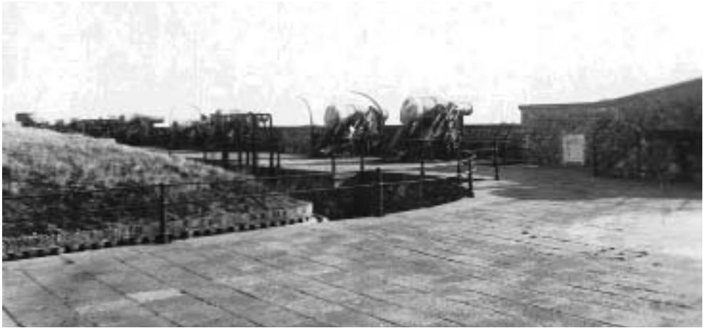
Fig. 17. Messina: la batteria Menaia, già ribattezzata Crispi. L'immagine si riferisce infatti a un periodo successivo alla guerra italo-turca e al primo conflitto mondiale. Si notano sul fronte d'attacco quattro coppie di pezzi da 28 cm corti incavalcati su affusti idropneumatici Armstrong. La batteria è tutt'oggi esistente, seppur in stato di grave rovina e abbandono. (Coll. F. Riccobono)
