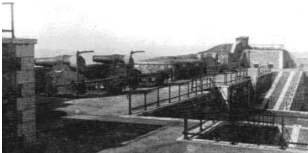
Fig. 15. Messina, batteria Serra la Croce: il piano delle artiglierie armato con due coppie di obici corti da 28 cm come quelli descritti nella figura 3, suddivise dalla riservetta centrale. Si notano in fondo uno dei due casotti telemetrici corazzati che sovrasta il locale elevatori, e più a destra il pilastro su cui è fissato il sistema parafulmine a spandente. (Coll. F. Riccobono)
