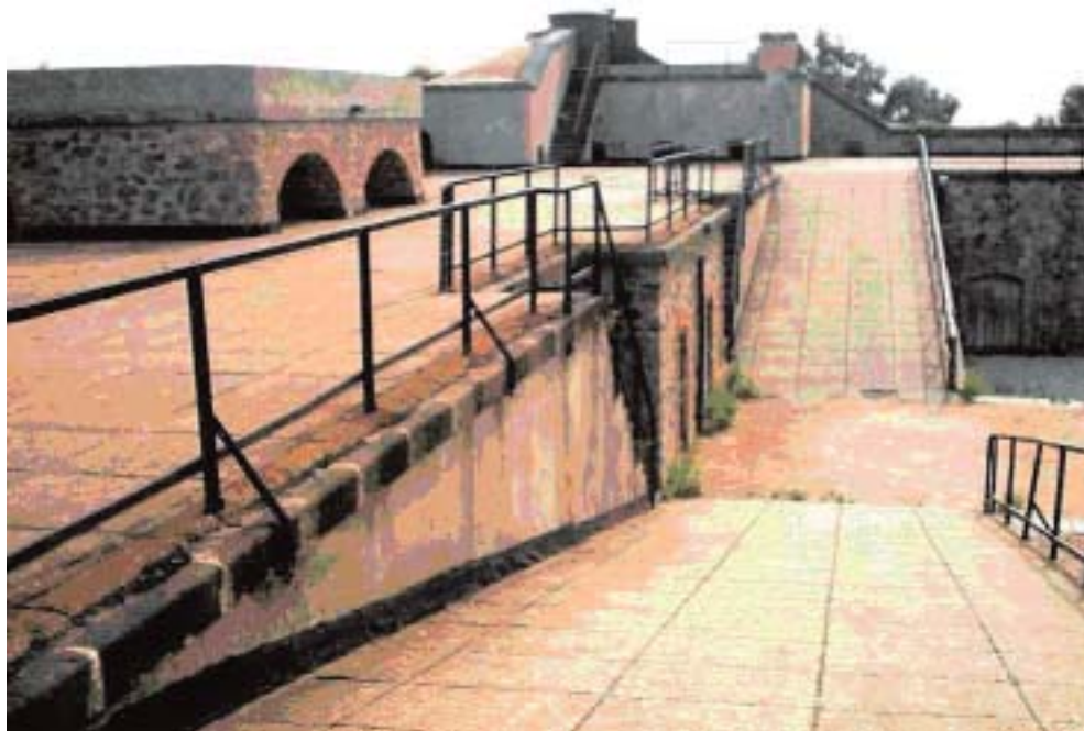
Fig. 16. La batteria Serra la Croce oggi, perfettamente conservata. L'opera presenta vari lavori di intonacatura e ripavimentazione insieme al rialzamento della copertura della riservetta centrale. Ciò insieme agli evidenti segni lasciati dalla più moderna griglia parafulmine, indica riusi successivi al periodo storico qui trattato. (Foto A. Donato)
