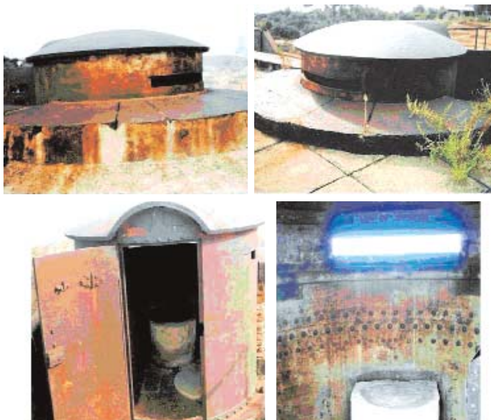
Fig. 2. Messina. Batteria Serra la Croce: i casotti telemetrici corazzati con la grande feritoia centrale. All'interno si nota il portello scorrevole per la feritoia e il supporto circolare in pietra sul quale era posizionato lo strumento. I casotti telemetrici sono accessori originali ormai molto rari che andrebbero meglio tutelati e conservati. (Foto A. Donato)
