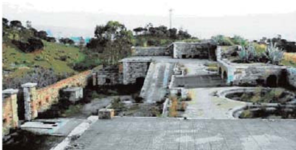
Fig. 18. Reggio Calabria. La batteria Pentimele Nord, ribattezzata Pellizzari, del tutto uguale alla batteria Serra la Croce. Si nota in particolare il piano delle artiglierie con le due coppie di piazzole circolari per obice corto da 28 cm, separate dalla riservetta centrale. (Foto R. Rugari)
