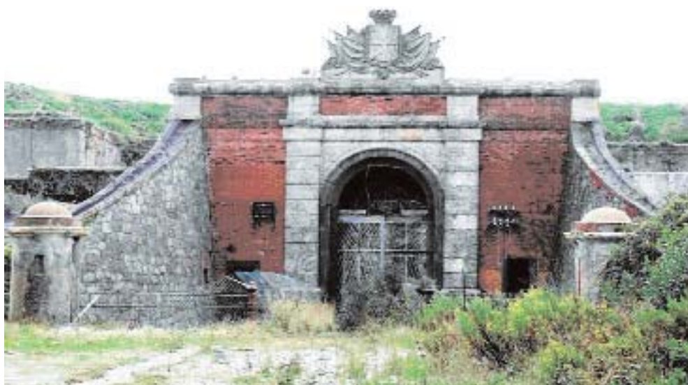
Fig. 14. Messina: l'imponente ingresso a porta reale della batteria Polveriera poi Masotto, sormontato dallo stemma del Regno d'Italia. L'ingresso è dotato di ponte levatoio a contrappesi utile a oltrepassare il profondo fossato secco perimetrale che cinge la cospicua fortificazione. Oggi l'opera ormai dismessa versa in stato di abbandono. (Foto A. Donato)
