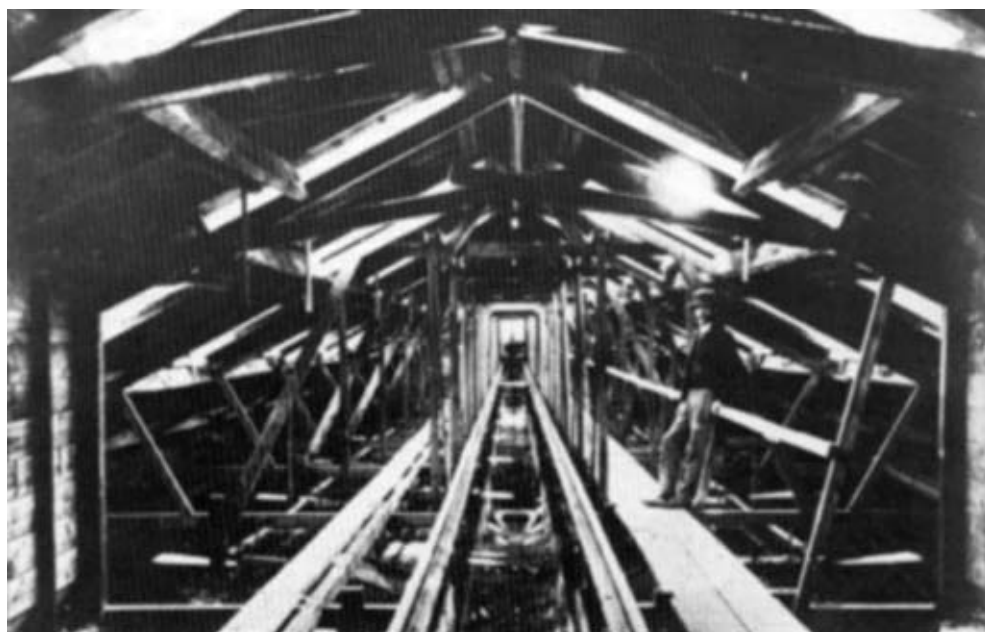
La prima vasca navale per esperienze idrodinamiche, chiamata Admiralty Experiment Works (A.E.W.), ideata da William Froude ed inaugurata nel 1872 a Torquay, in Gran Bretagna. (Da internet)
