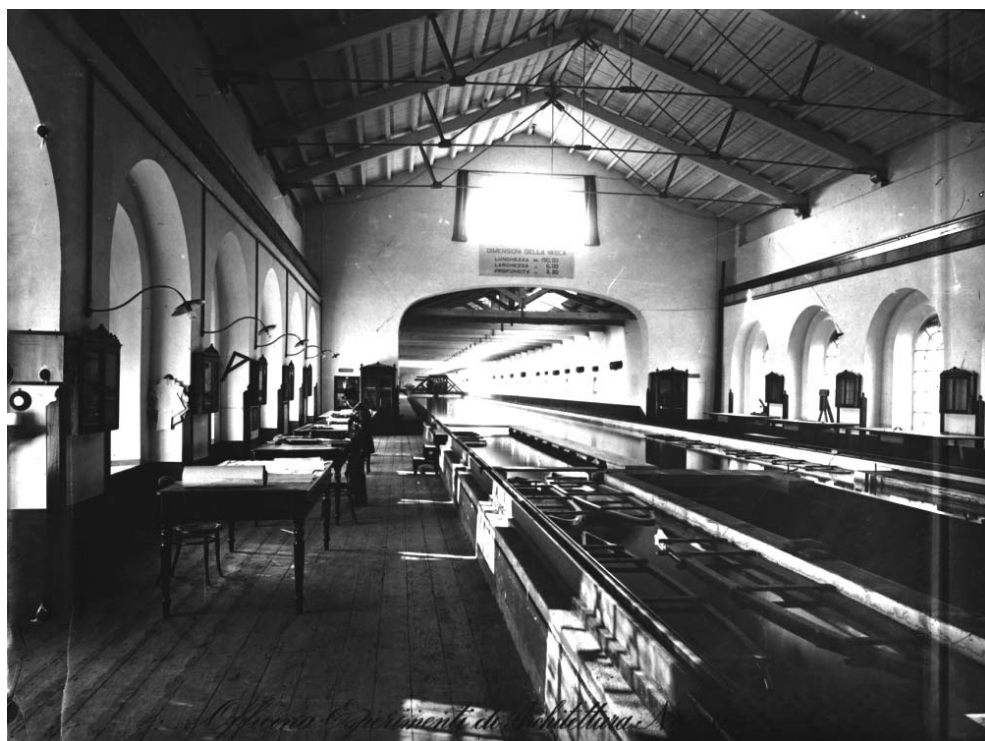
L'interno del capannone della vasca navale della Spezia. (Fonte: Marina Militare)
