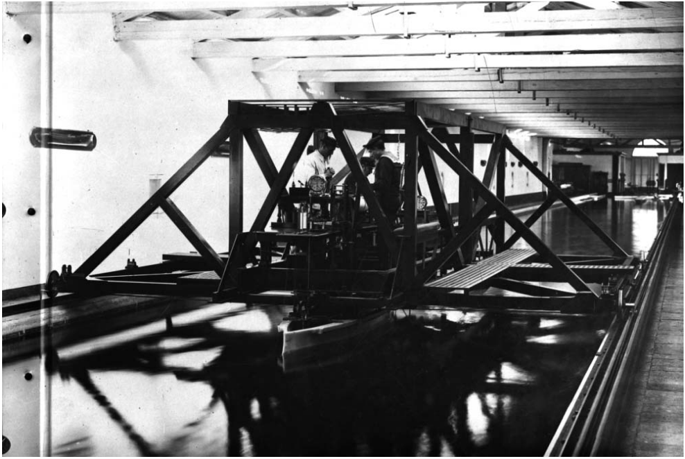
Immagine del carro dinamometrico per le carene della Vasca Navale della Spezia, ripresa nel corso di una prova di modello. (Fonte: Marina Militare)
