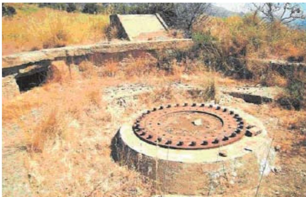
Fig. 21. Due esempi di batterie messinesi di nuova concezione. *Sopra*: Capo d'Alì, batteria costiera *Margottini*: piazzola per cannone da 152/45 con relativa piastra; dietro, l'ingresso alla riserverta munizioni ipogea di pronto impiego, dotata di apertura per il trasferimento dei proiettili al pezzo.
