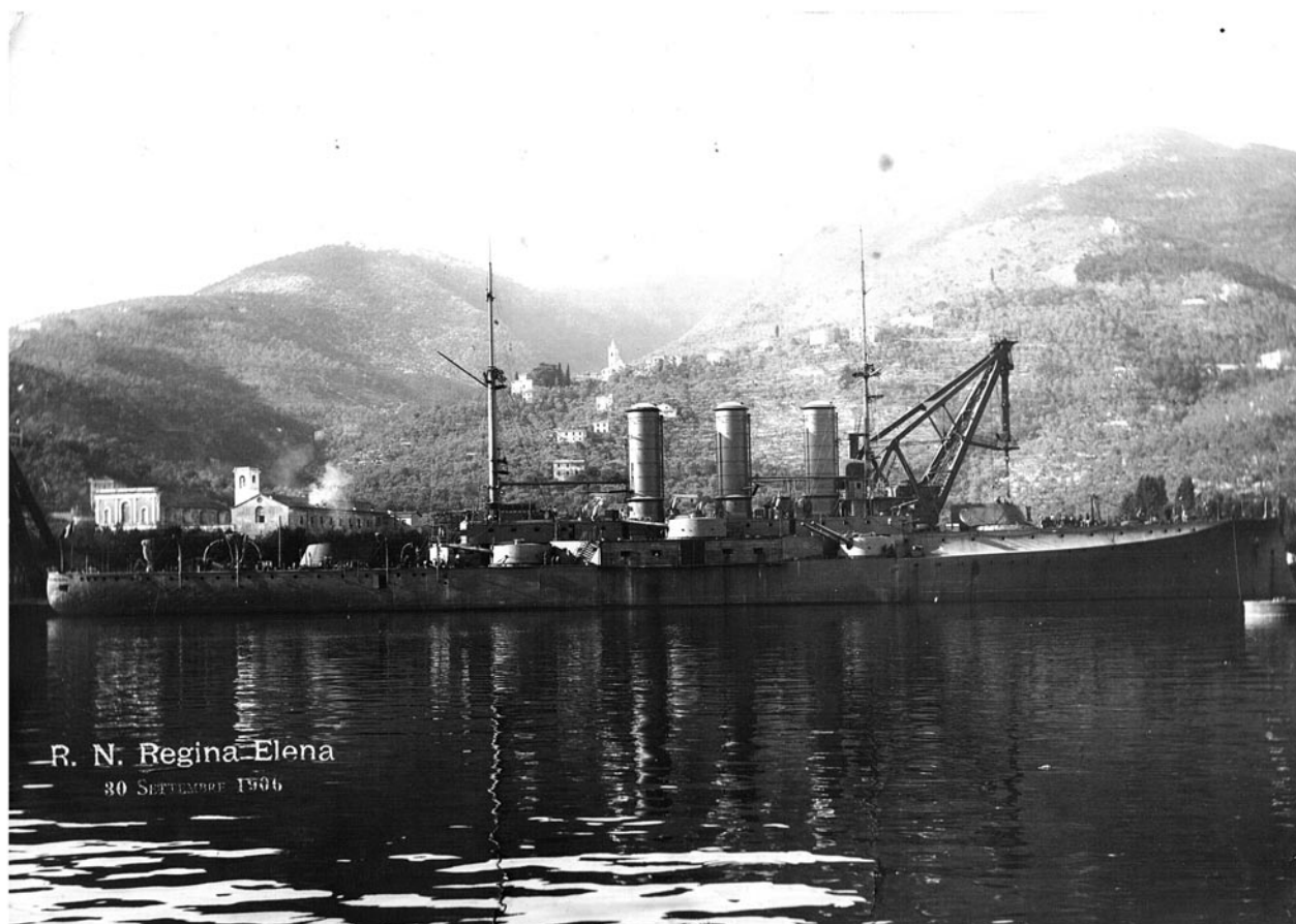
Fig. 1 – Installazione dell'armamento principale sulla Nave da battaglia Regina Elena , la Spezia 30 settembre 1906 (Arch. USMM, fondo Bonfiglietti)
