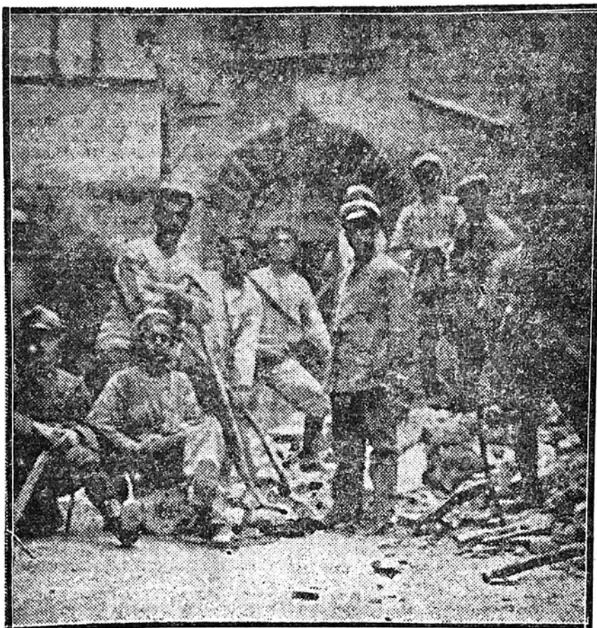
UNA SQUADRA DI SOCCORSO DI MARINAI A FIVIZZANO
