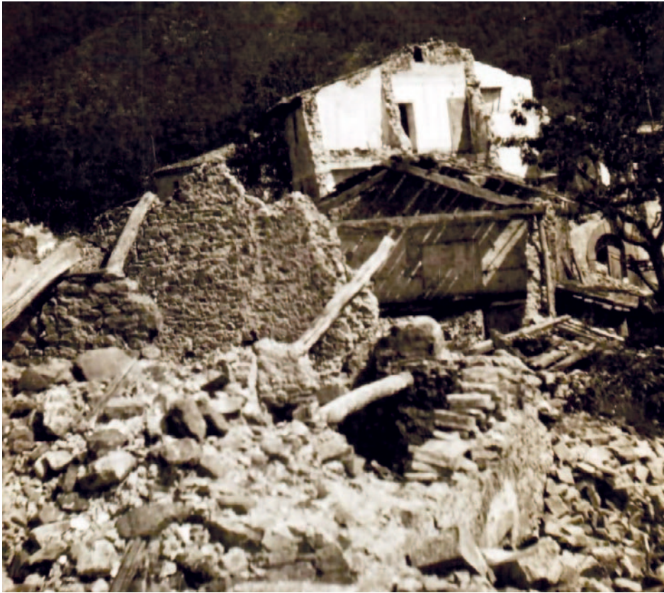
Fig. 14 – Villa Collemandina, ruderi di via Fillungo; in secondo piano i resti del Municipio e di casa Dinelli (collezione Silvio Fioravanti)
