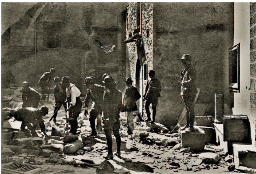
Fig. 8 – Fivizzano, soldati al lavoro per lo sgombero delle macerie (collezione Silvio Fioravanti)
