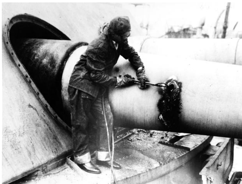
Fig. 12 – La rimozione del sistema di caricamento della torre poppiera dalla nave da battaglia giapponese Shikishima (敷島), della classe omonima, trasformata in nave ausiliaria in ottemperanza del trattato di Washington, Arsenale di Sasebo, 14 novembre 1923 (NH 95750, U.S. Naval History and Heritage Command)
