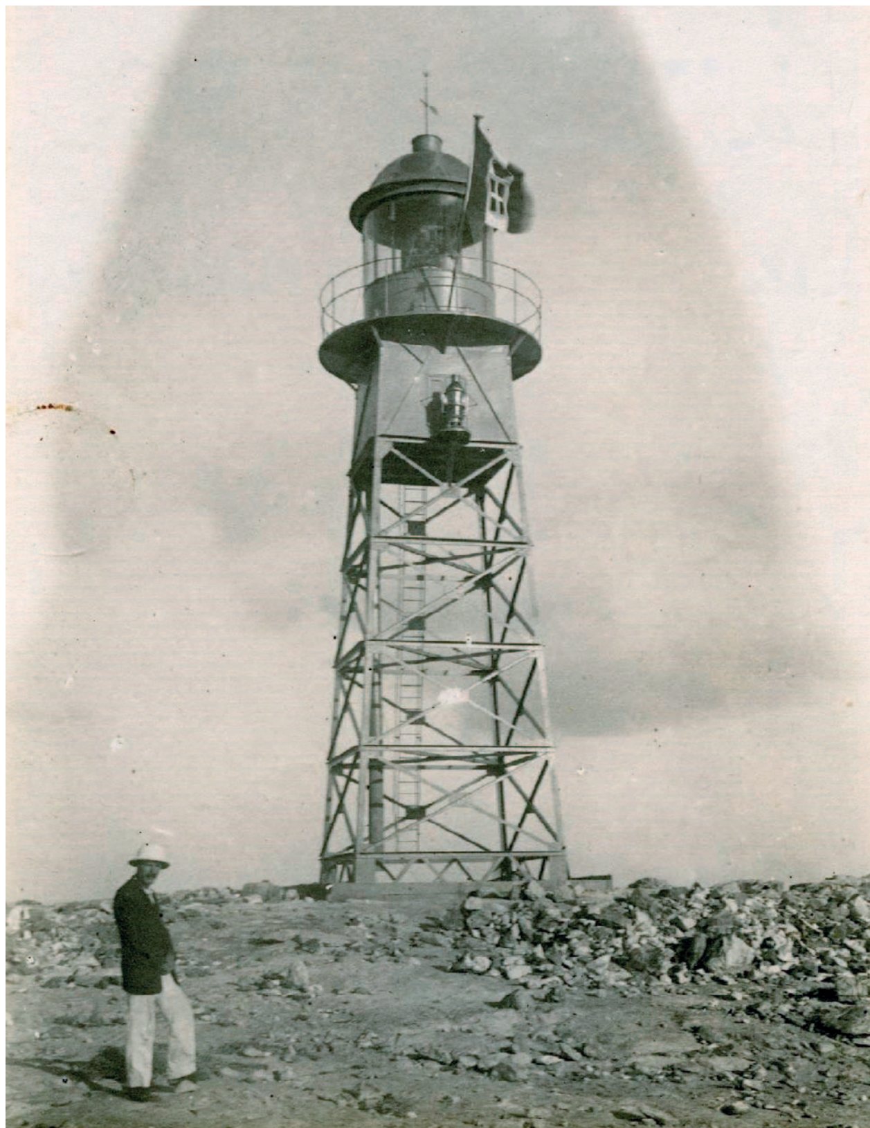
Fig. 24 – Il faro Crispi appena terminato (Collezione Autore)
