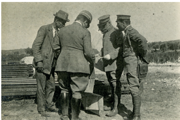
Venezia. Thaon di Revel e Guido Po in visita a un cantiere, 1917-1918.
