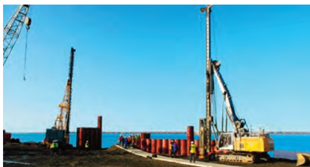
Le infrastrutture portuali e terrestri dell'impianto nucleare di cogenerazione Akademik Lomonosov di Pevek in fase di costruzione nell'ottobre 2016 (Fonte: Rosenergoatom).
