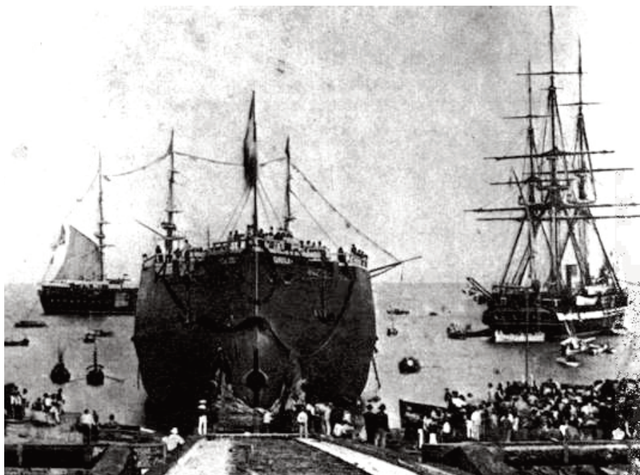
Varo della corazzata DANDOLO, 10 luglio 1878, progettata da Benedetto Brin, fu la prima grande nave costruita in arsenale e fu a lungo la più potente corazzata in servizio (Fonte: Archivio Storico Arsenale).
