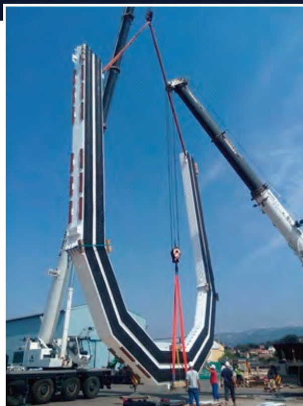
Il cassone stagno in acciaio con giunti in gomma (chiamato batardeau ) utilizzato per poter effettuare all'asciutto le lavorazioni di manutenzioni del giunto di collegamento della diga «Ranieri III» con la terraferma, chiamato «rotula» ( gouv.mc ).
