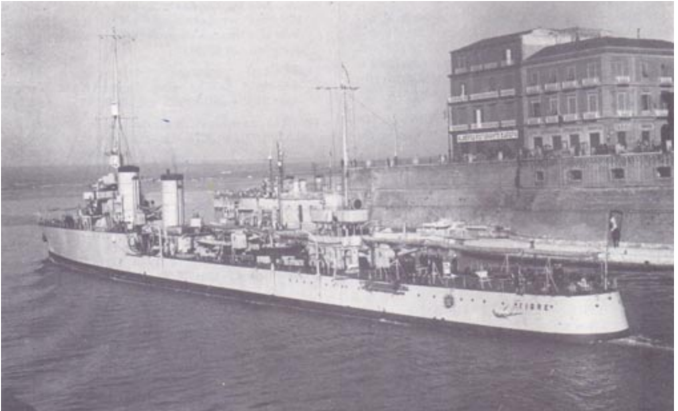
L'esploratore (poi riclassificato cacciatorpediniere) Tigre nel 1932. Navi bene armate (8 cannoni da 120 mm) e di ridotta autonomia, erano state progettate durante la Grande Guerra per operare in Adriatico. (USMM)
