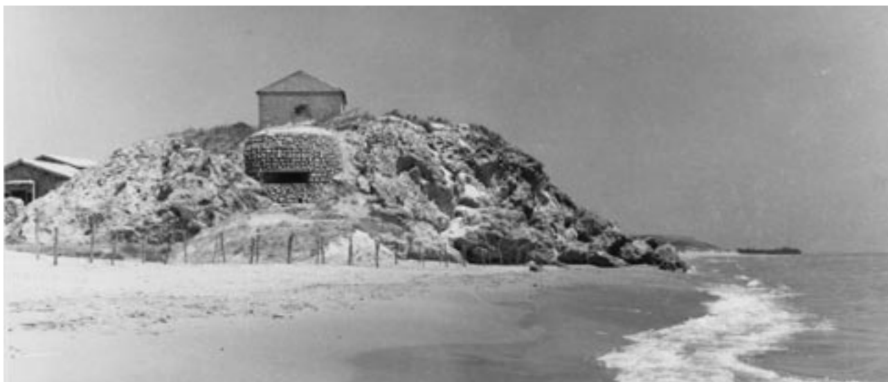
Un bunker italiano della difesa costiera in Sicilia. Si trattava di opere progettate nel 1941 dimostratesi, già l'anno successivo, troppo piccole per ospitare i fino ad allora non previsti cannoni controcarro da 47 mm e, secondo il giudizio espresso dai tedeschi nel 1943, troppo vulnerabili a causa, in primo luogo, delle feritoie troppo ampie (NHHC).
