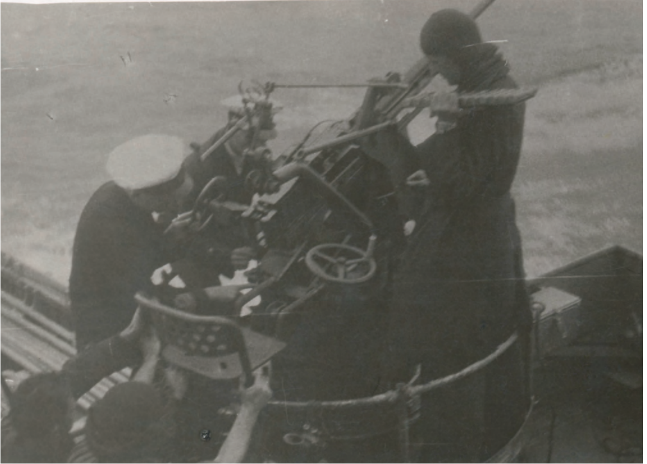
Una mitragliera terrestre Breda da 20 mm del Regio Esercito catturata in Egitto nel dicembre 1940 e saldata a bordo dell'incrociatore australiano SYDNEY . A causa degli sforzi di compressione e strappamento esercitati sugli improvvisati basamenti di bordo, queste armi si rivelarono spesso più pericolose per gli anglosassoni che non per il nemico (g.c. Peter Cannon).
