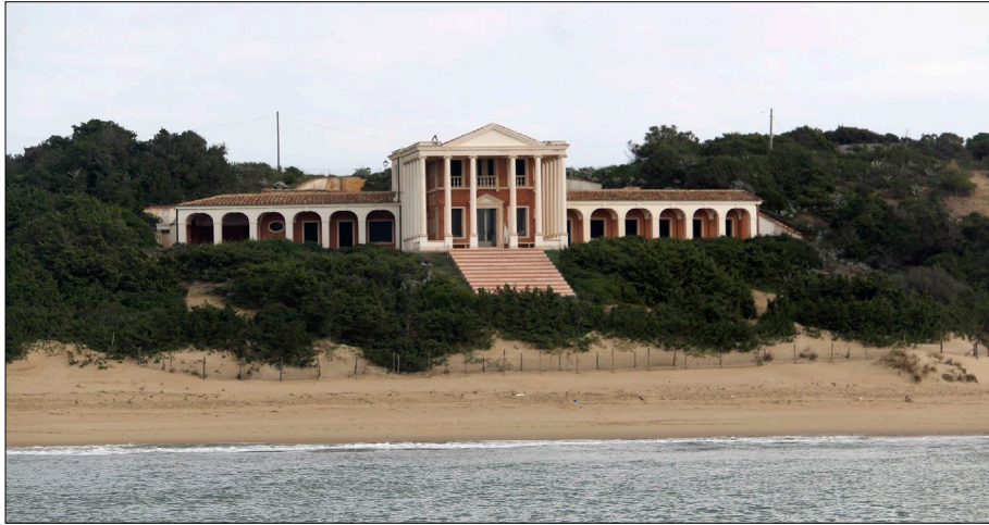
Figura 90c - Edificio con ampio colonnato (2019).
